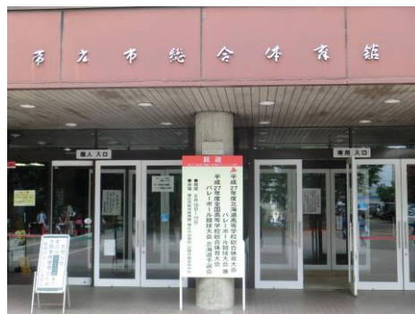
帯広市総合体育館
